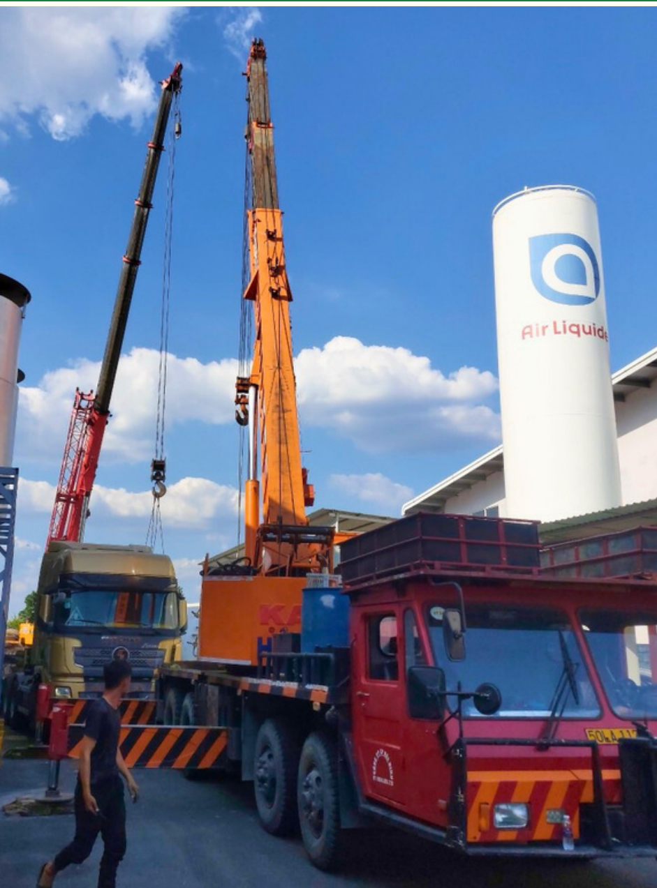
Kato 50 tấn và 100 tấn lắp đặt bồn chứa khí CO2
