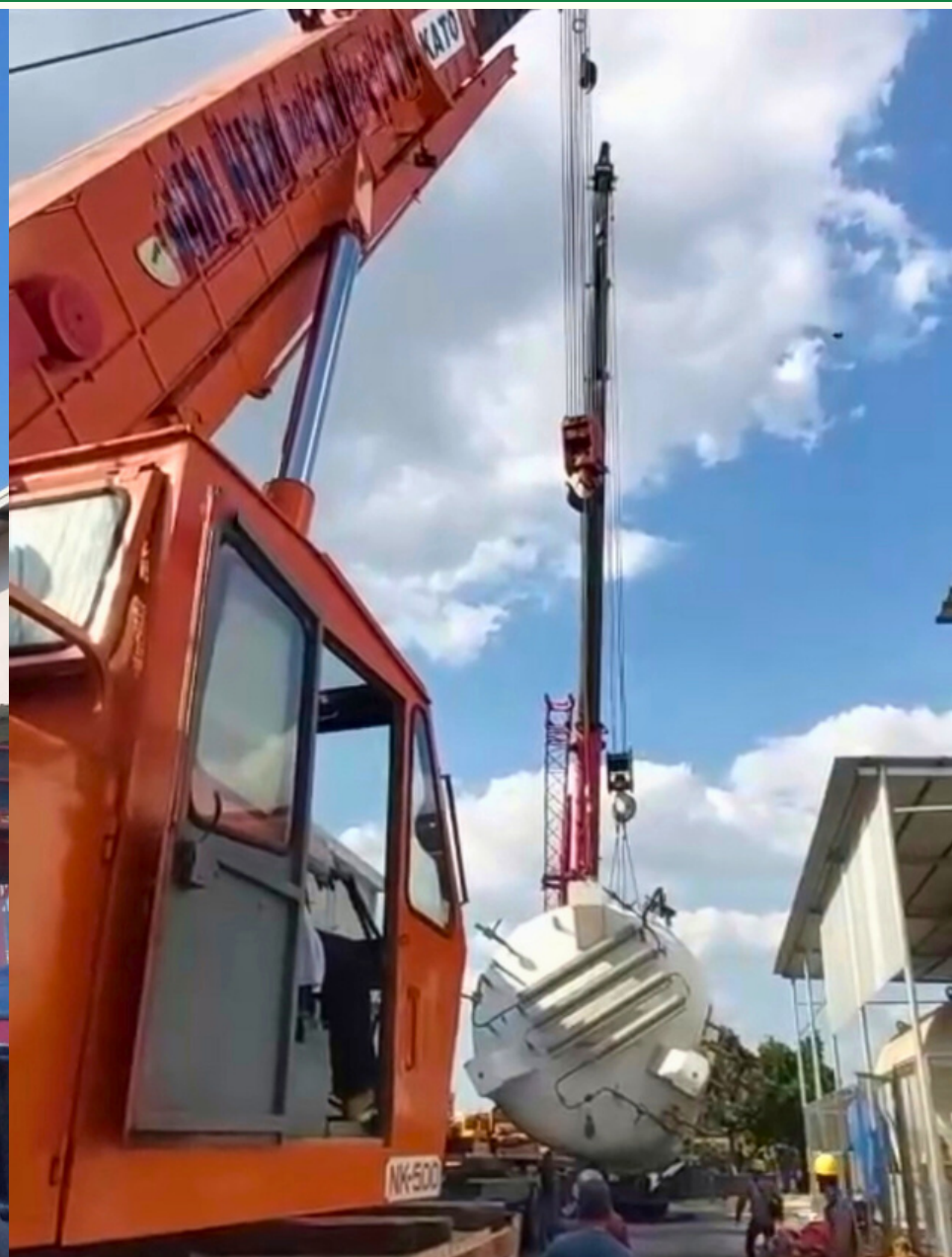
Kato 50 tấn và 100 tấn lắp đặt bồn chứa khí CO2
